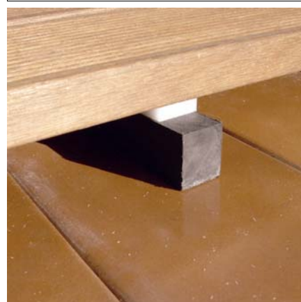
i. terakota istniejąca lub proj., spadek 0 – 2,5 %, alternatywnie terakota tylko w pasach pod legarami montażowymi deck-u → detal nr 04
