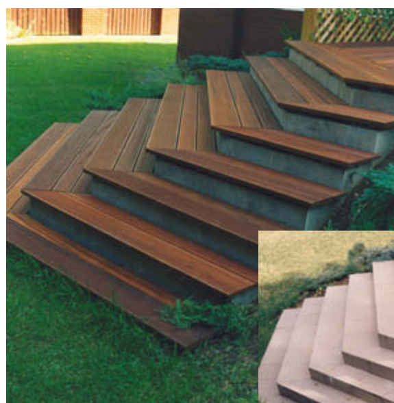
deck – deska drobno-ryflowana bangkirai 1,8 x 8,8 cm / deck z 1,5% spadkiem / na terakocie / schody – deska płasko-ryflowana bangkirai 2,2 x 14,0 cm / impregnat - 2 x olej lniany
