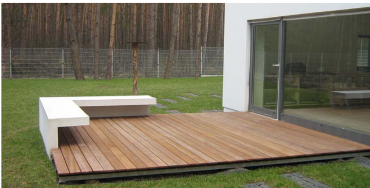
deska iroko , gładka 10,8 x 2,0 cm / polietylenowe podkładki 1,3 cm + polietylenowe legary montażowe deck-u 3,0 cm / deck poziomy / podłoże – kontr. stalowa na słupkach betonowych
